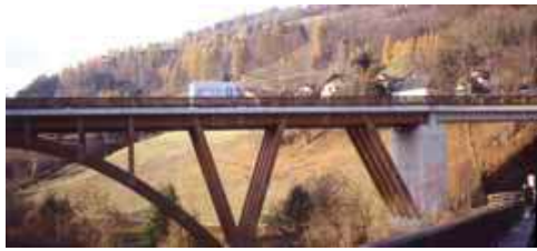
Karayolu köprüsü, Graz, Avusturya
