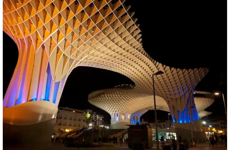
Şekil 5. Teknolojik bir yapı Metropol Parasol İspanya ahşap yapı elemanlarından LVL kullanımı
