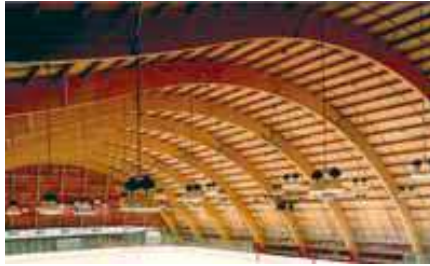
Şekil 4. tutkallı lamine Ahşap buz pateni yapısı. A.B.D. Norman Foster
